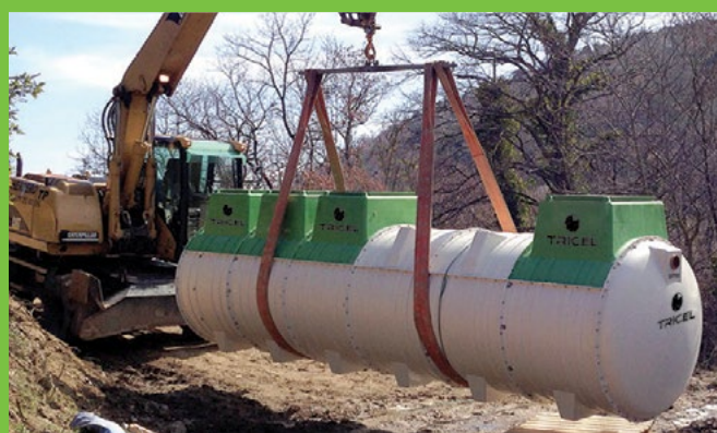
Installation d'une Tricel Novo FR20
