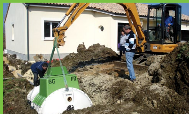
Installation d'une Tricel Novo FR6
